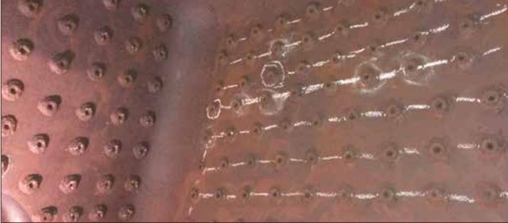
▲ Die Innenseite der Feuerbüchse, in der normalerweise das Kohlefeuer brennt. Die weißen Striche an der Wand zeigen, in welchen Stehbolzen die Kontrollbohrungen frei sind. Dort wo Kreise zu sehen sind, konnte die Kontrollbohrung nicht frei gemacht werden – diese Bolzen müssen ausgetauscht werden.
